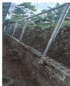
Foto 6: Reparación de muros perimetrales
