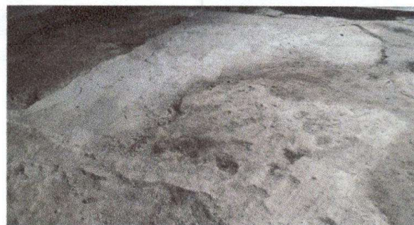
Foto 2: Sustrucción de piso de torta de concreto
