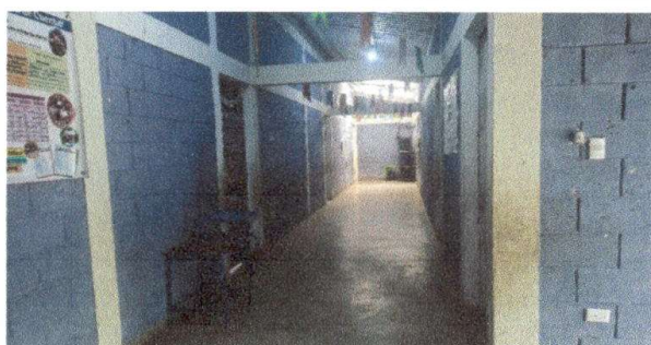
Foto 5: Pintura en muros interiores y exteriores
