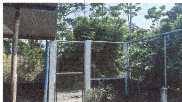
Foto 4: Sustrucción de portón
